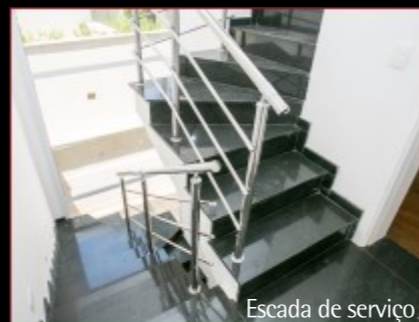
Escada de serviço
